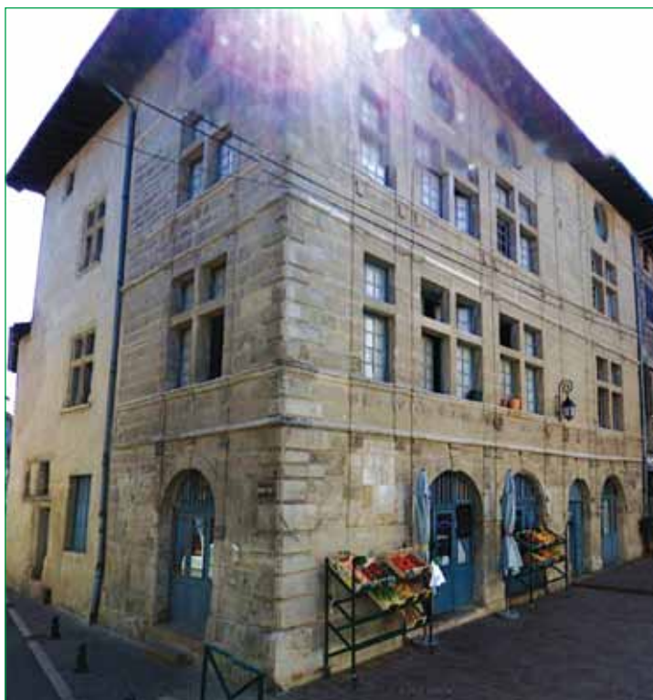
Figure 1 : Le bâtiment test de notre étude.
